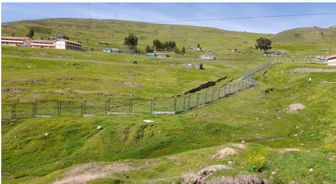
FIGURA N°03: EN LA TEMPORADA DE MAXIMAS AVENIDAS, LA QUEBRADA TIKAPALLANA PARALELA A CERCO DE INSTITUCION EDUCATIVA INUNDA Y EN LA PARTE BAJA EROSIONA CON SOCAVAMIENTO.
